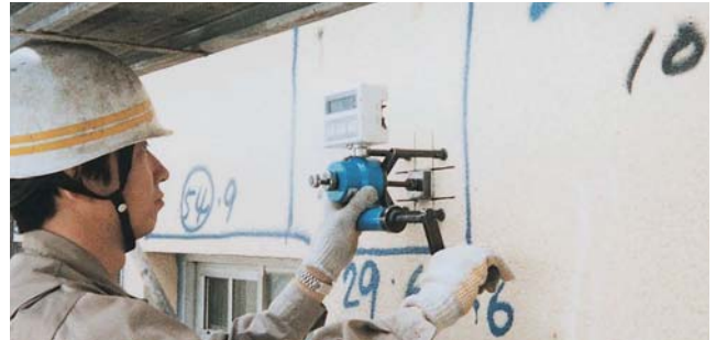
〈ピンニング工法の補修効果確認例〉
