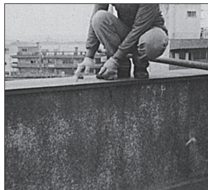
パラペット天端の施工
