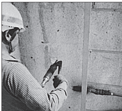
モルタル面への施工
